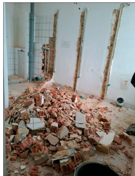
Rekonstrukce WC v budově úřadu.
