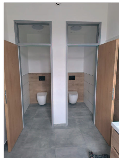
WC radnice po rekonstrukci.
