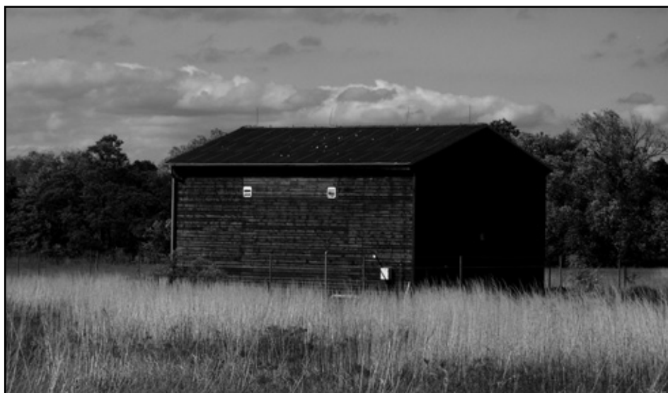
čistička odpadních vod
